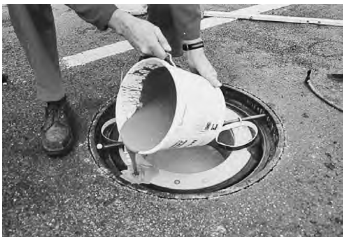
Schlauchschalung Fig. 3280 einsetzen, Addiment Schachtbeton Art. 913142 einfüllen
