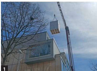
1 Kran-Ablad Déchargement avec grue
